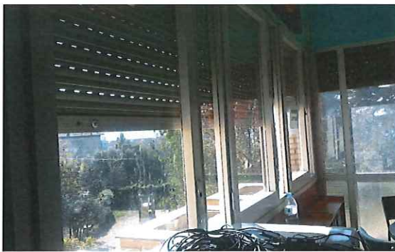
Foto 10. Finestra situada a la façana
