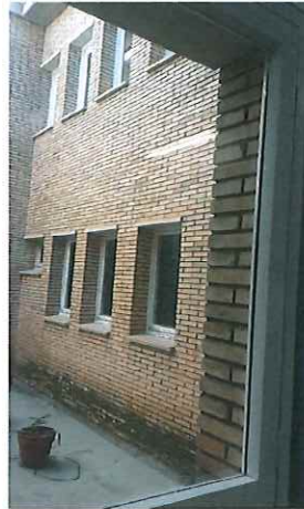
Foto 2. Finestres situades al pati interior
