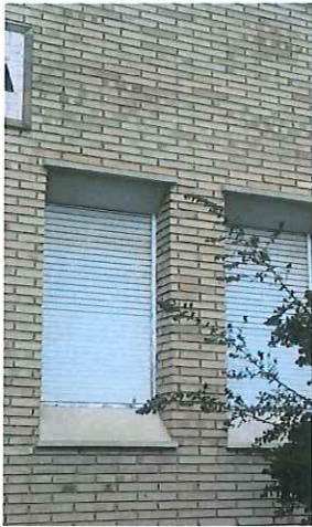
Foto 1. Vista general finestra façana
