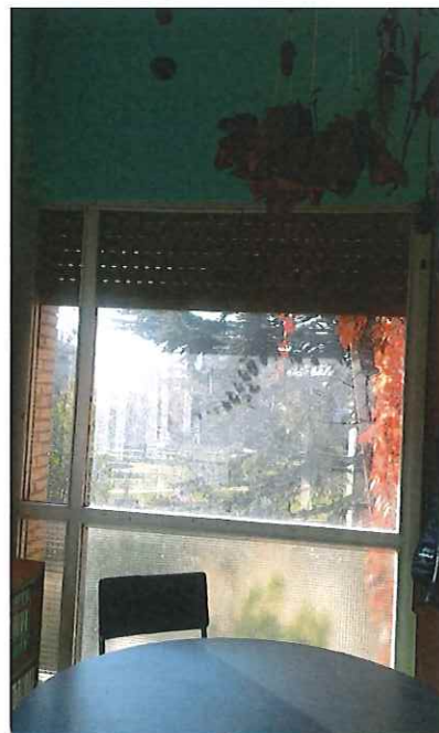
Foto 12. Vidriera situada a la façana
