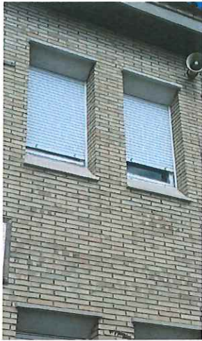
Foto 7. Vista general finestra façana
