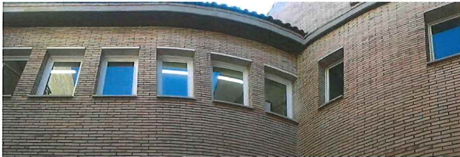
Foto 9. Finestres situades al pati interior
