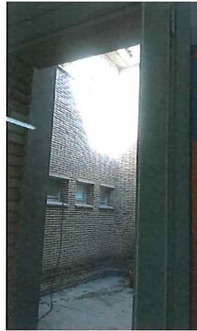
Foto 8. Finestres situades al pati interior
