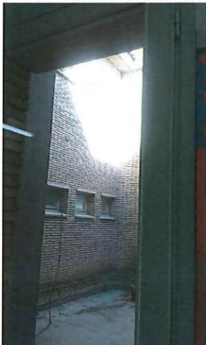
Foto 3. Finestres situades al pati interior
