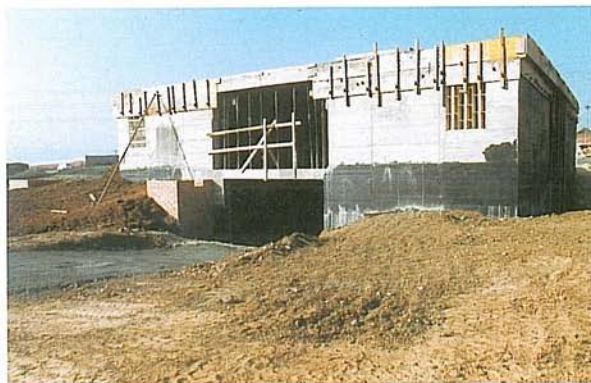
Construcció de la Casa de Natura
