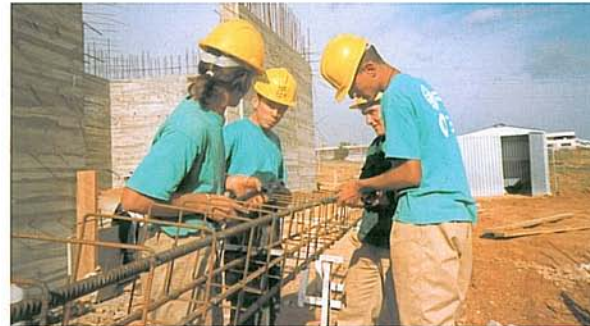
Dos moments de la construcció de la Casa de Natura
