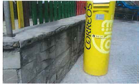
Foto 16. Bústia pròxima al mur perimetral
