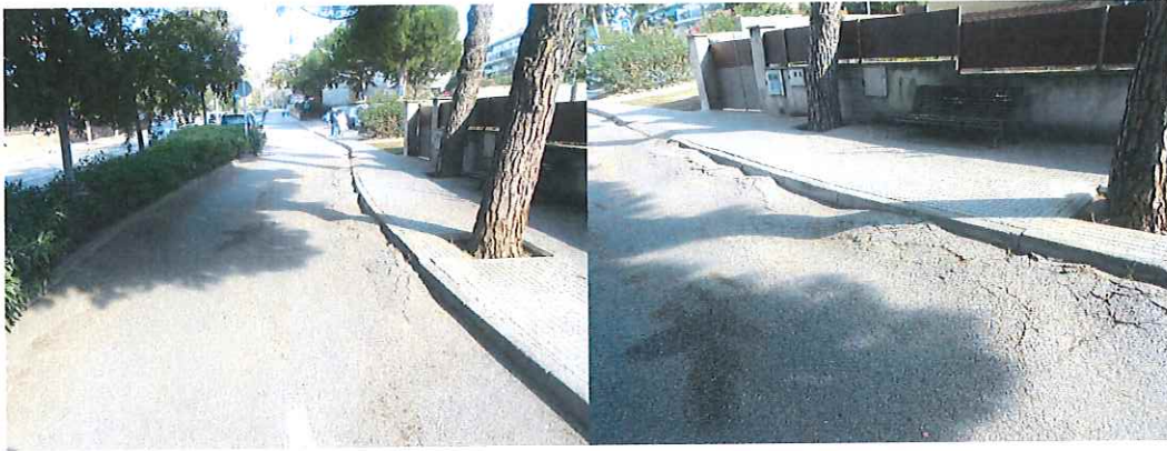
Carrer Balmes entre carrer Tarragona i carrer Montcada – Reparació afectació arrels.
