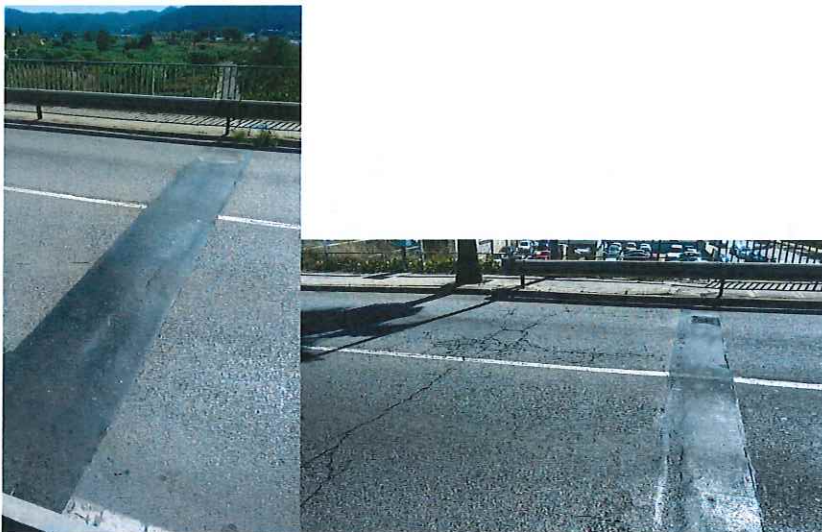
Carrer Tarragona entre CAP II i carrer Verge de Montserrat – Reasfaltat i juntes pont – Cruïlla carrer Tarragona amb carrer Can Masachs.
