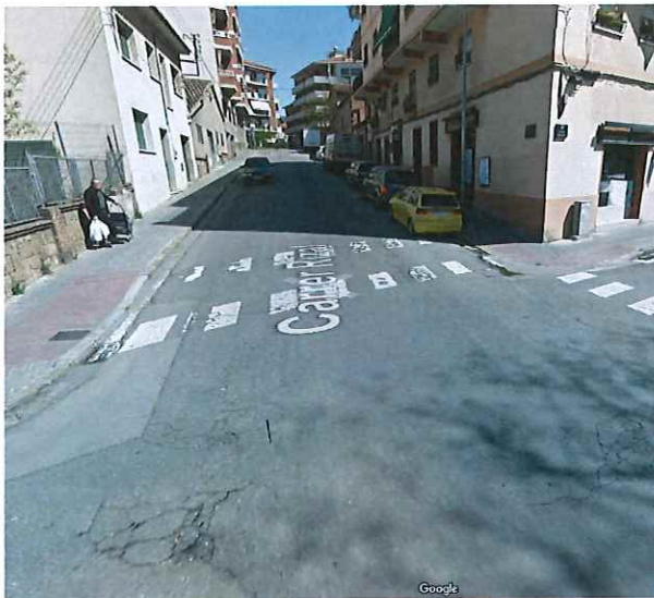
Carrer Rizal entre carrer Monturiol i Rambla Sant Jordi – Reasfaltat.
