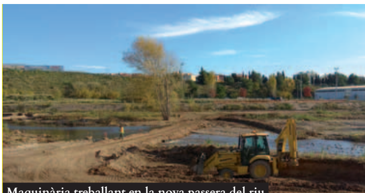
Maquinària treballant en la nova passera del riu
