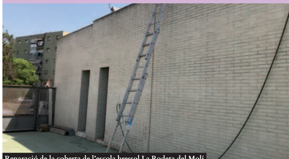
Reparació de la coberta de l'escola bressol La Rodeta del Molí
