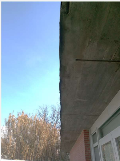
Foto 2. Zona reparada del lateral
