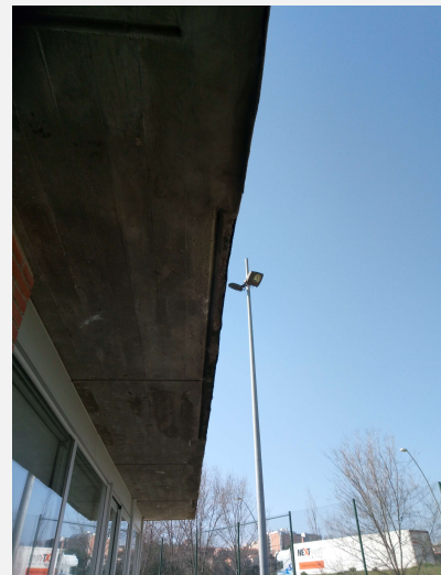
Foto 3. Zona reparada del lateral
