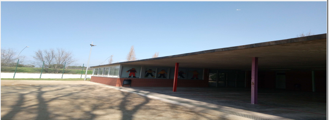
Foto 10. Vista general de la coberta
