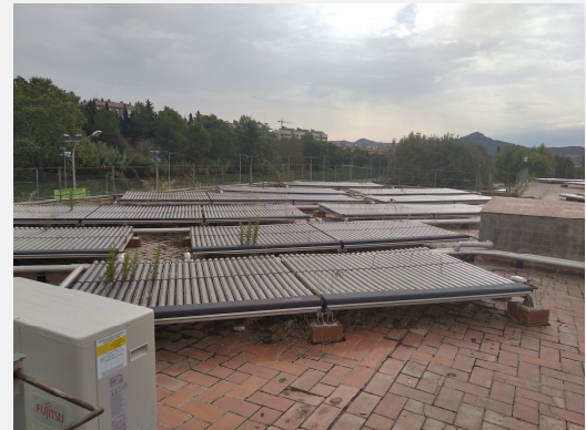
Foto 11. Detall coberta superior
