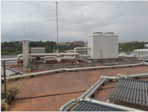
Foto 8. Detall coberta superior
