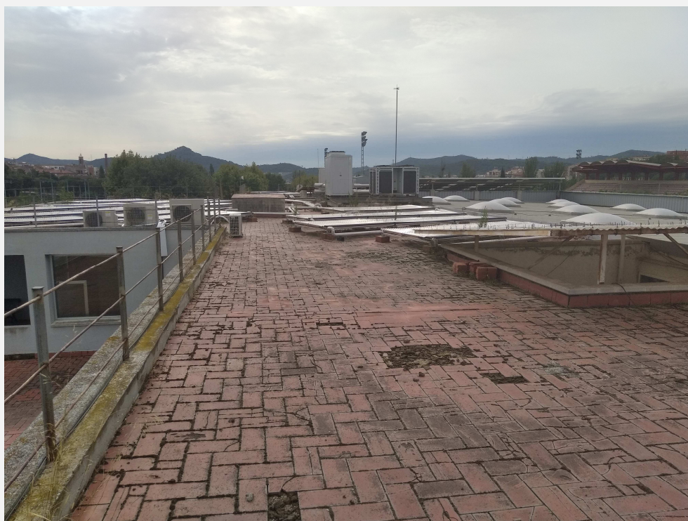
Foto 1. Vista general de la coberta superior
