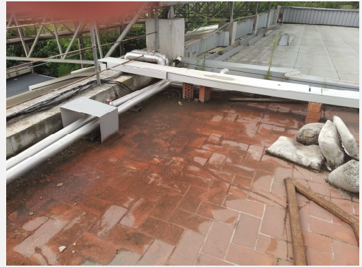
Foto 9. Detall coberta superior
