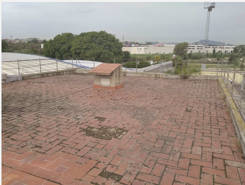
Foto 2. Vista general de la coberta superior
