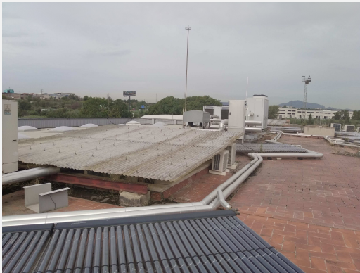
Foto 10. Detall coberta superior
