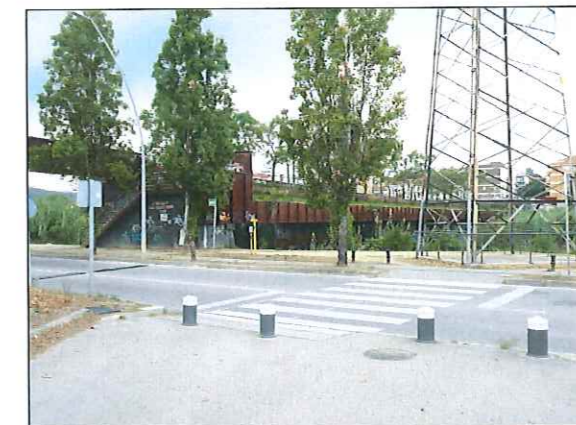
GRUP SEMAFÒRIC S02 : Confluència Avinguda Riu Ripoll amb Carretera de l'Estació.
